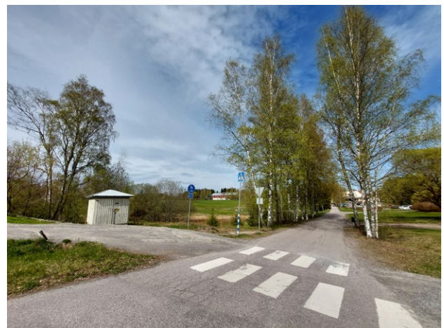
Kuva 35. Näkymä kunnantalolta Krapille on osittain sulkeutunut. Muuntamorakennus toimii risteyksialueen maamerkinä.
