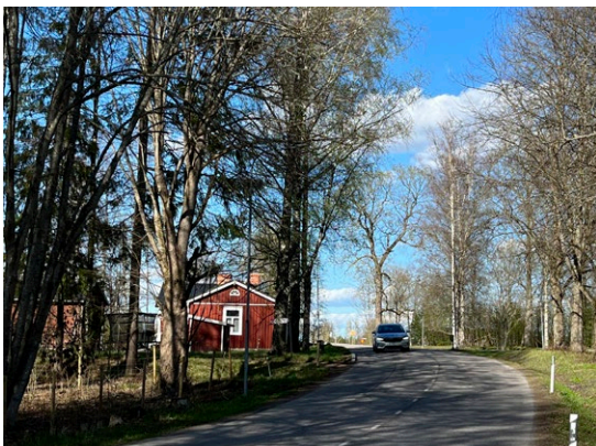
Kuva 27. Kotun päärakennus on Kirkkotiessä kiinni ja toimii tiemaiseman maamerkinä. Rakennus on jäänyt kuitenkin kuoppaan, kun nykyinen tie on rakennettu ylemmäksi.
