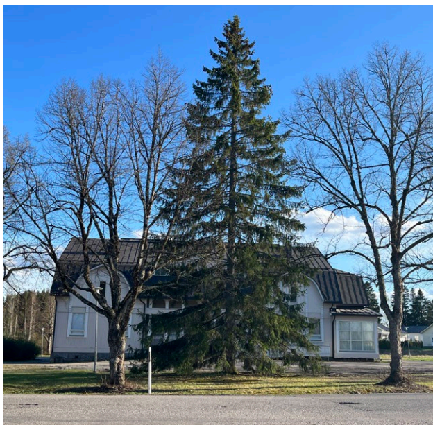
Kuva 33. Kunnantalon näkymälinja ja hieno pääjulkisivu peittyvät ison kuusen taakse. Risteyksessä sijaitsevaa ja kulttuurihistoriallisesti arvokasta julkisivua voitaisiin korostaa esim. valaistuksella.
